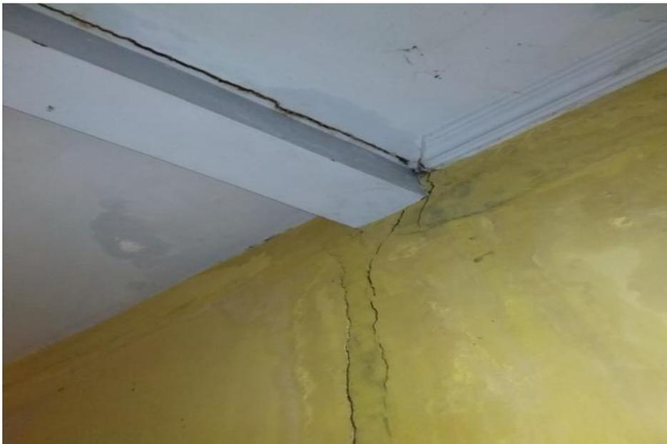
Gambar 1 Keretakan pada sekitar balok dan kolom
